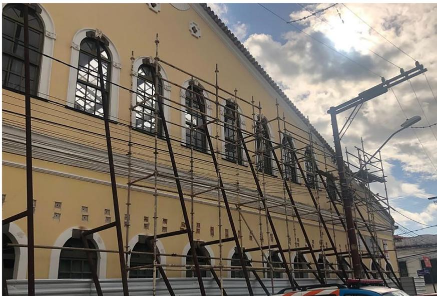
FIGURA 9 - Edificação com escoramento inclinado na área de estudo.
